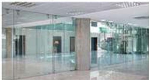
این نوع شیشه ها شامل دو یا چند لایه شیشه اند که بوسیله ورقه های از نایلون شفاف تحت حرارت و فشار به هم متصل می شوند. همچنین بعض از انواع شیشه های طلق دار به عنوان عایق صوت، جاذب حرارت، کاهنده شفاقت و شیشه ایمنی پکار بردگه می شوند. وقتی که این شیشه ها می شکنند، خاصیت کشسانی نایلون مانع از پخش و پراکندگی ذرات شیشه می گردد.
